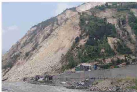
映秀地震断裂上盘地震滑坡 位于映秀地震断裂上盘的汶川县映秀镇, 陡峻的岷江东岸在主震的诱发下产生地震滑坡, 掩埋了都汶公路, 造成高架桥严重损毁 5月19日杨农摄
