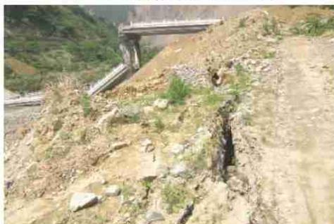
地震造成湔江大桥垮塌, 左岸产生裂缝宽达0.5米 5月18日张永双摄
